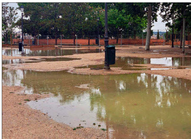
Charcos que se forman cuando llueve tras las obras. E. M.
