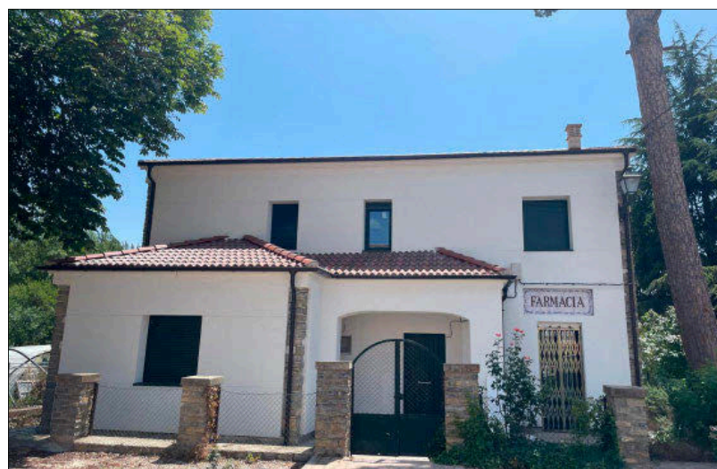
Villar concluye las obras del consultorio y la farmacia. MARIO TEJEDOR
