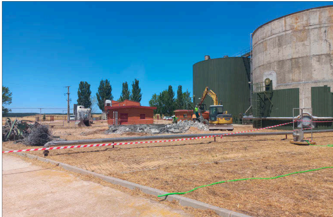
Obras de modernización en la planta de Redexis de Almazán. HDS
