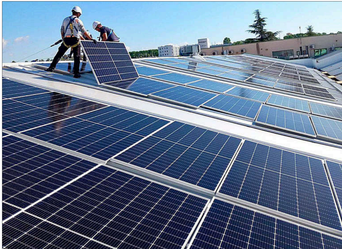
Los trabajadores instalan paneles solares en un edificio. E. M.
